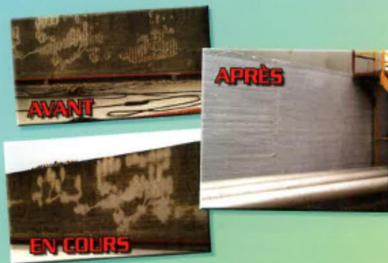
Revêtement époxy bicomposant en phase aqueuse : Résistance à la contrepression 5 bars.
